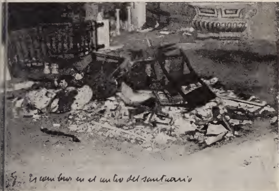
San Juan. — Escombros en el centro del santuario (Foto Lonraí).
